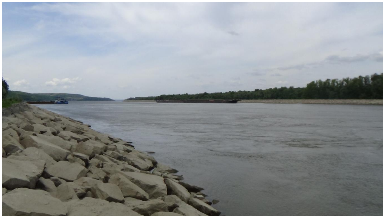
Fig. 2.1.1. - Transport piatră în zona punctul critic 01 - Bala
