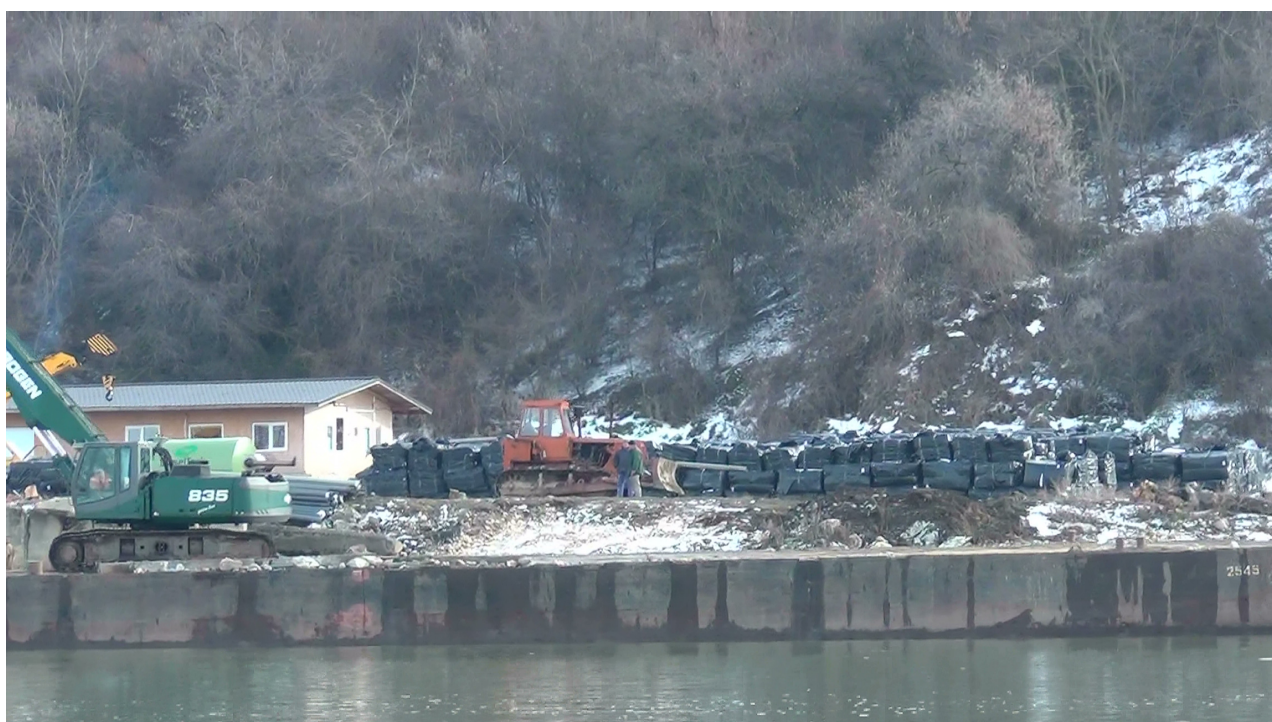
Fig. 2.1.1.I.2 - Depozit saltele geotextil în incinta organizării de santier
