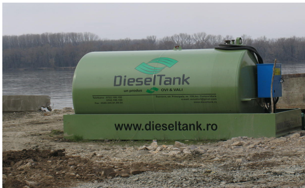
Fig nr.2.1.1.1.1 - Rezervor metalic stocare carburanți amplasat în cuvă metalică
