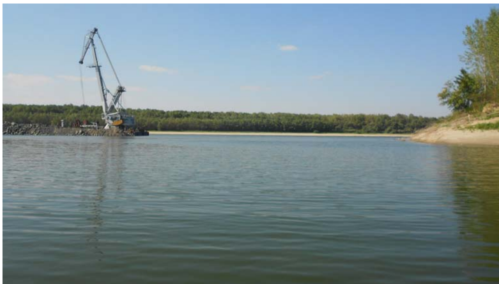
Fig. 2.1.2.1.1 - Lucrări la digul de dirijare PC02 - Braț Epurașu
