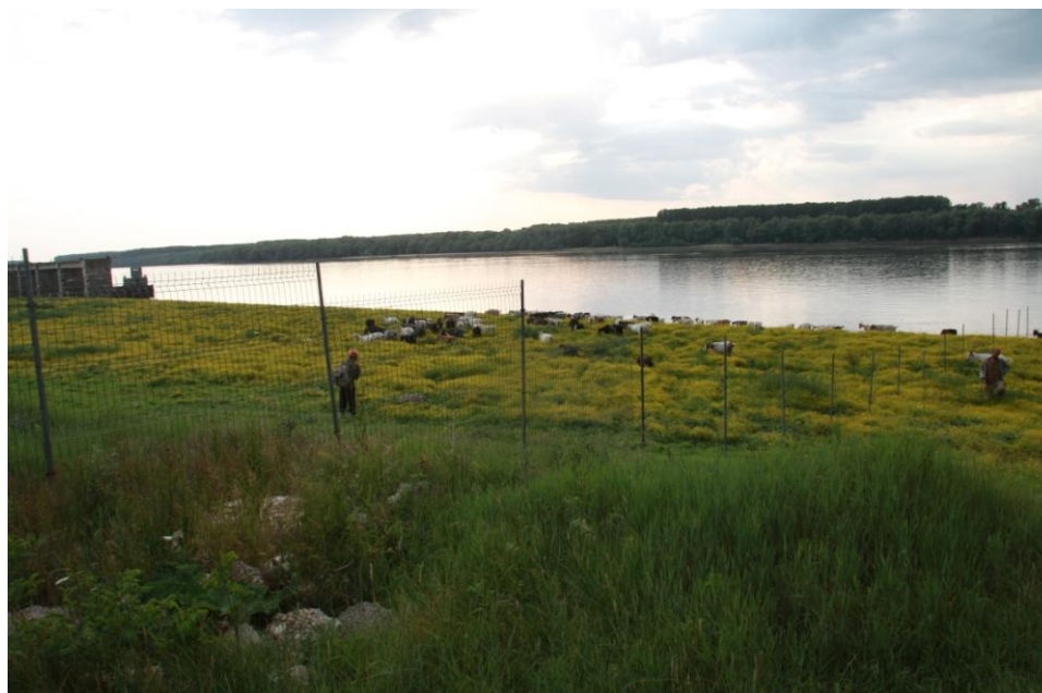
Fig. 3.1.1.5. Împrejmuirea amplasamentului organizării de șantier de la km 346
