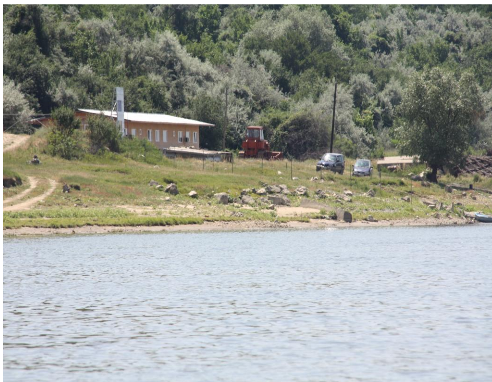
Fig. 3.1.1.1. Construcțiile organizării de șantier de la km 346
