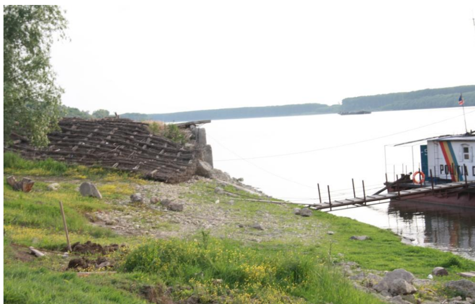
Fig. 3.1.1.6. Saltelele de fascine depozitate temporar în vederea transportului pe apă la alt amplasament
