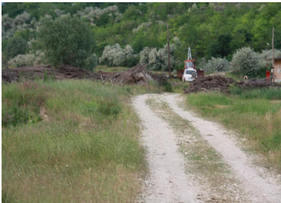
Fig. 3.1.1.3. Drumul de acces la amplasamentul organizării de șantier de la km 346 (spre localitatea Izvoarele)
