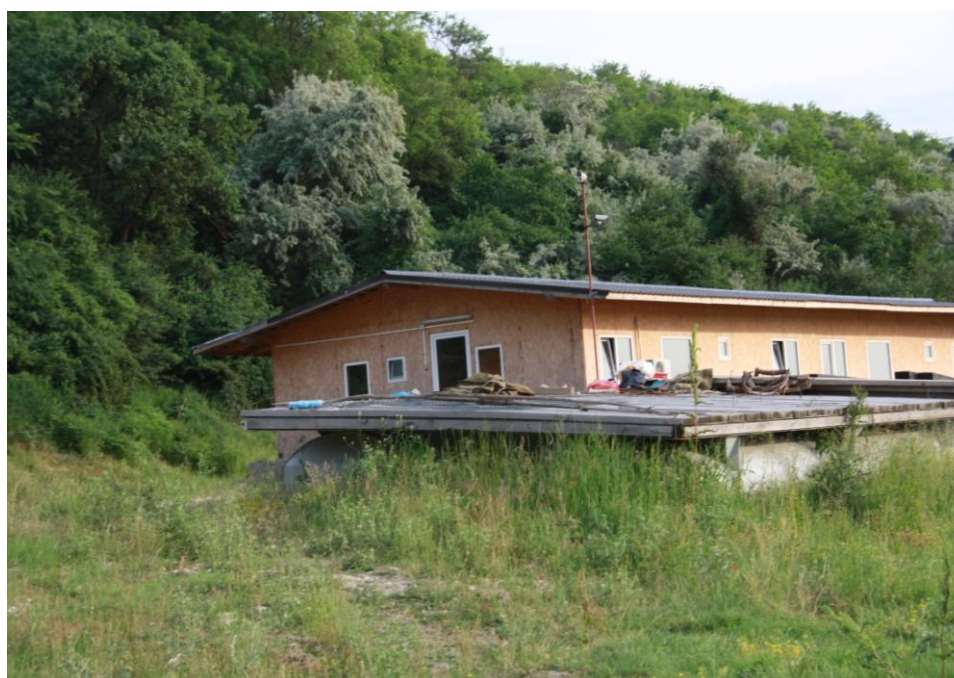
Fig. 3.1.1.2. Detaliul construcției principale în cadrul organizării de șantier de la km 346
