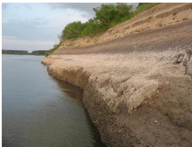
Fig. 3.1.F.is.29. Prag din argila tare la malul stâng al bratului Borcea, în zona Km 61 - 62 (25.05.2011)
