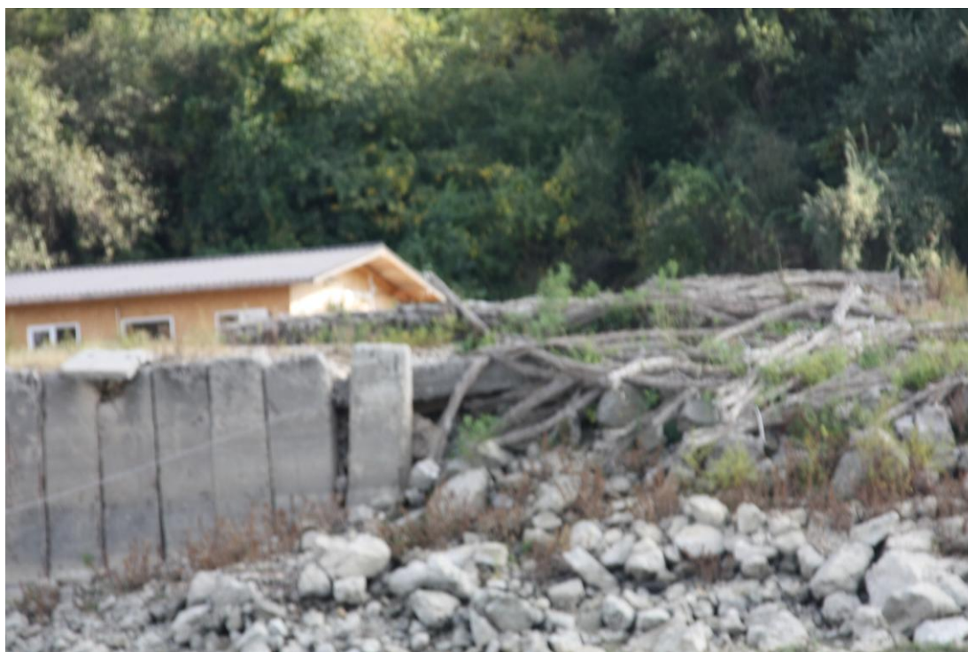
Fig. 3.1.I.8. Amplasamentul organizării de șantier la km 346 - Peisaj
