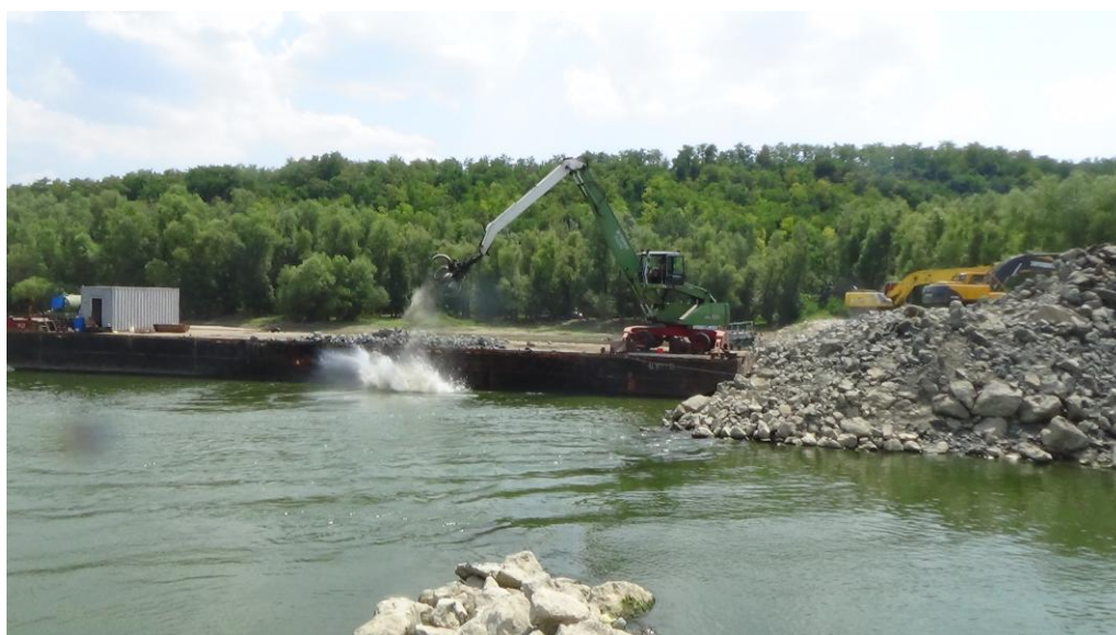
Figura nr. 2.1.2 - Lucrări în zona digului de dirijare, punctul critic PC02 - Insula Epurașu
