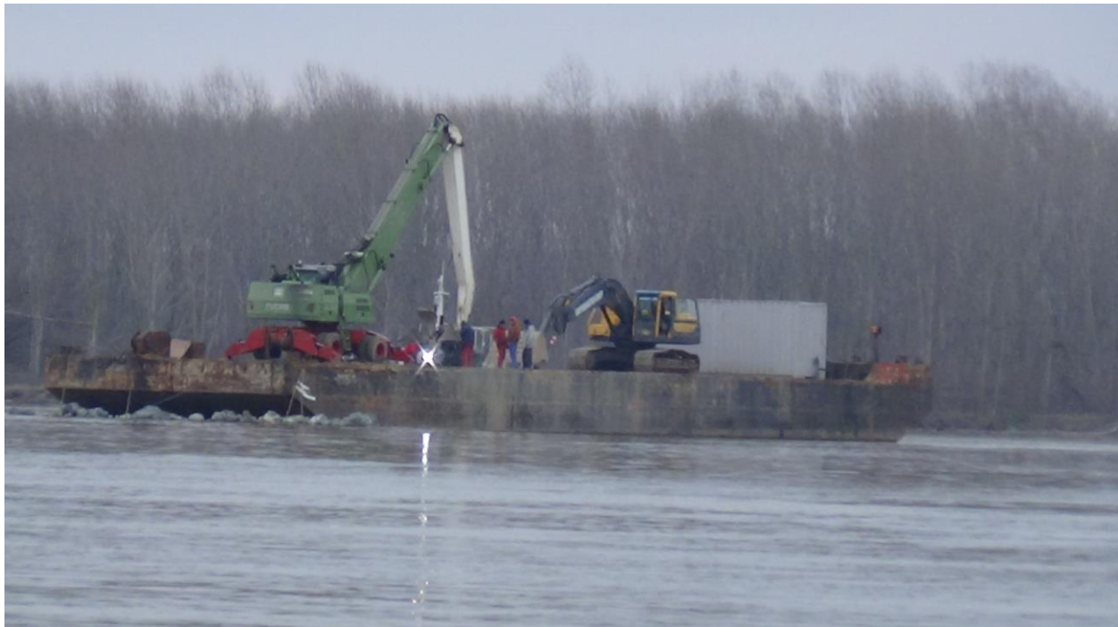
Figura nr. 2.1.2 - Activitate de șantier în zona Insula Epurașu
