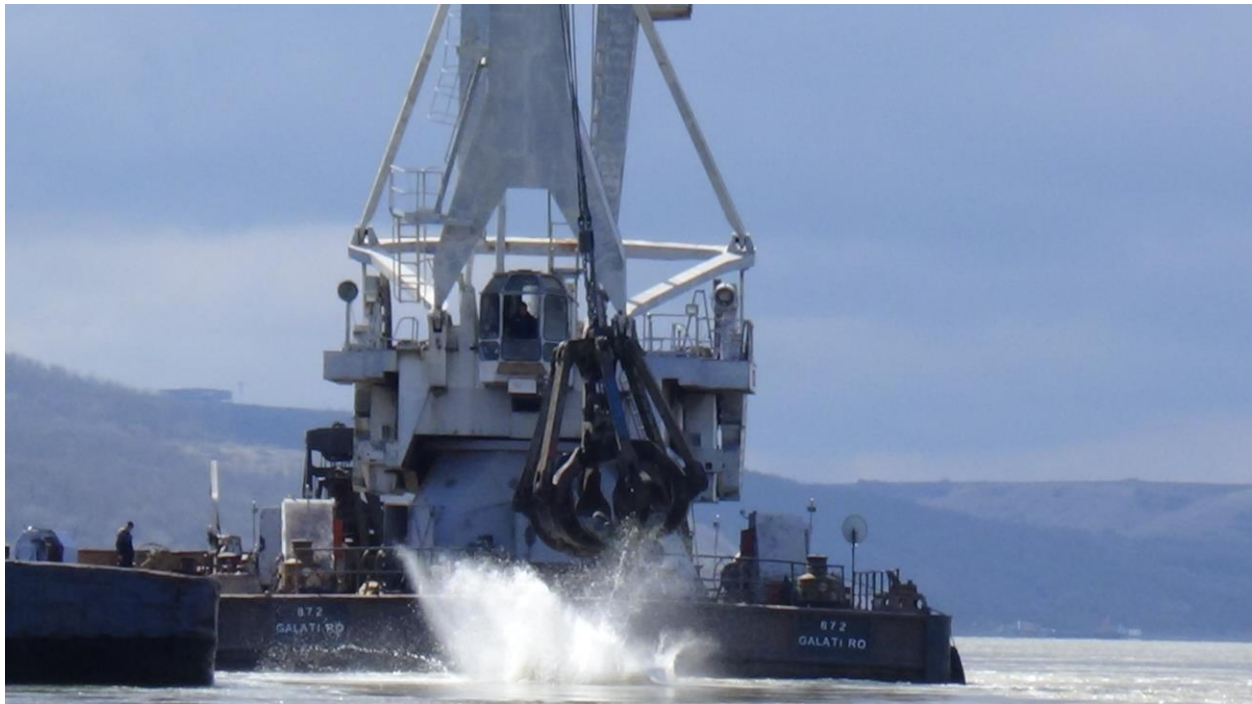
Fig.2.1.1. -Macara, lucrări prag de fund în zona Bala
