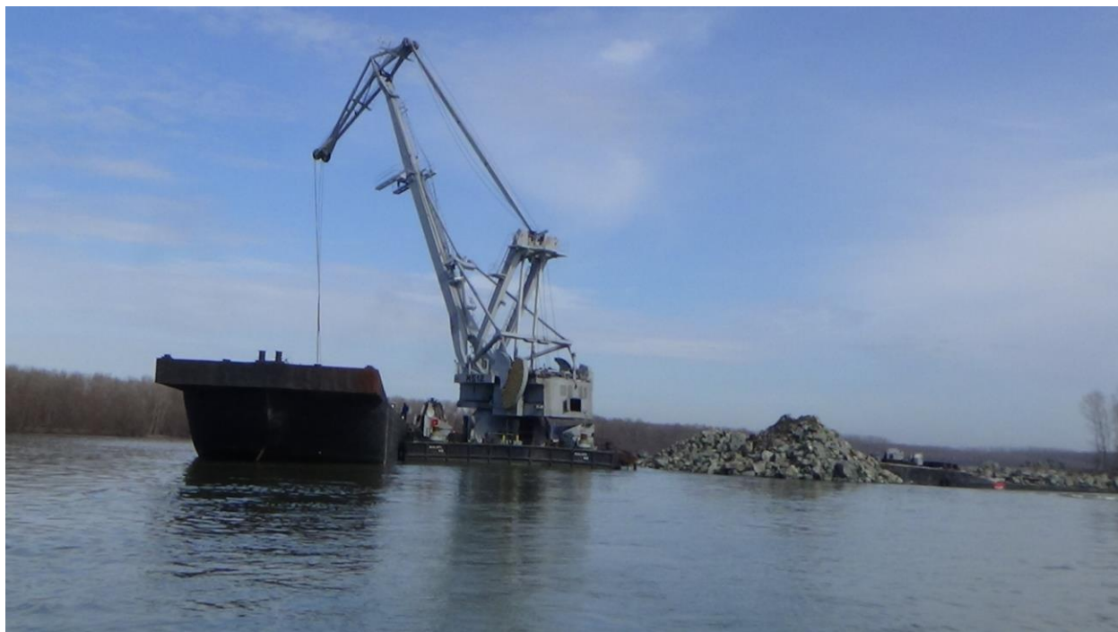
Fig.2.1.2. -Lucrări la digul de dirijare submersibilă, în zona PC 02 - Epurașu
