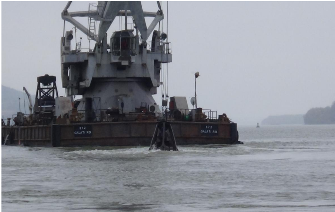
Figura 2.1.1. - Bala PC01- aranjarea pietrelor din zona pragului de fund, langa malul drept
