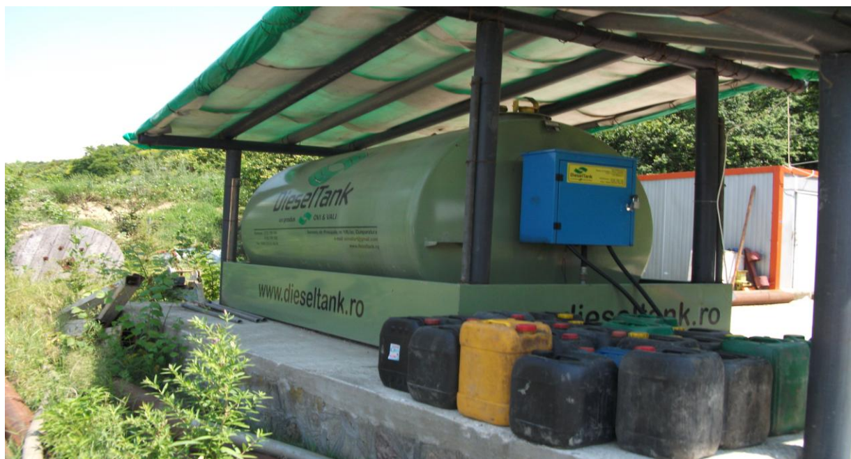
Fig.2.1.1 - Depozit de carburanți în zona organizării de șantier, PC 01
