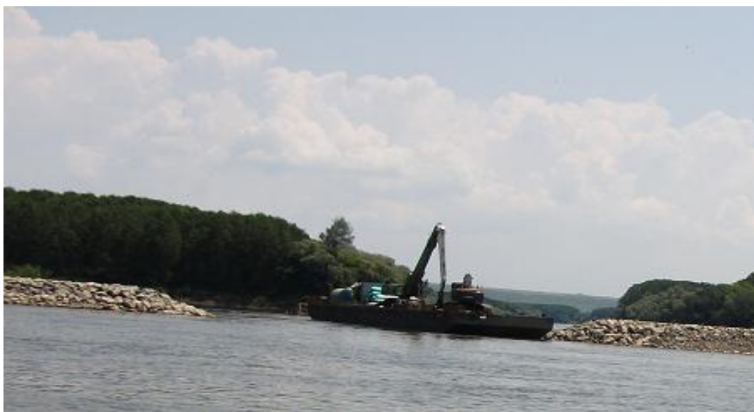
Fig. 2.1.2.1.1 - Pregătire pentru pozarea geotextilului în zona digului de dirijare, PC 02
