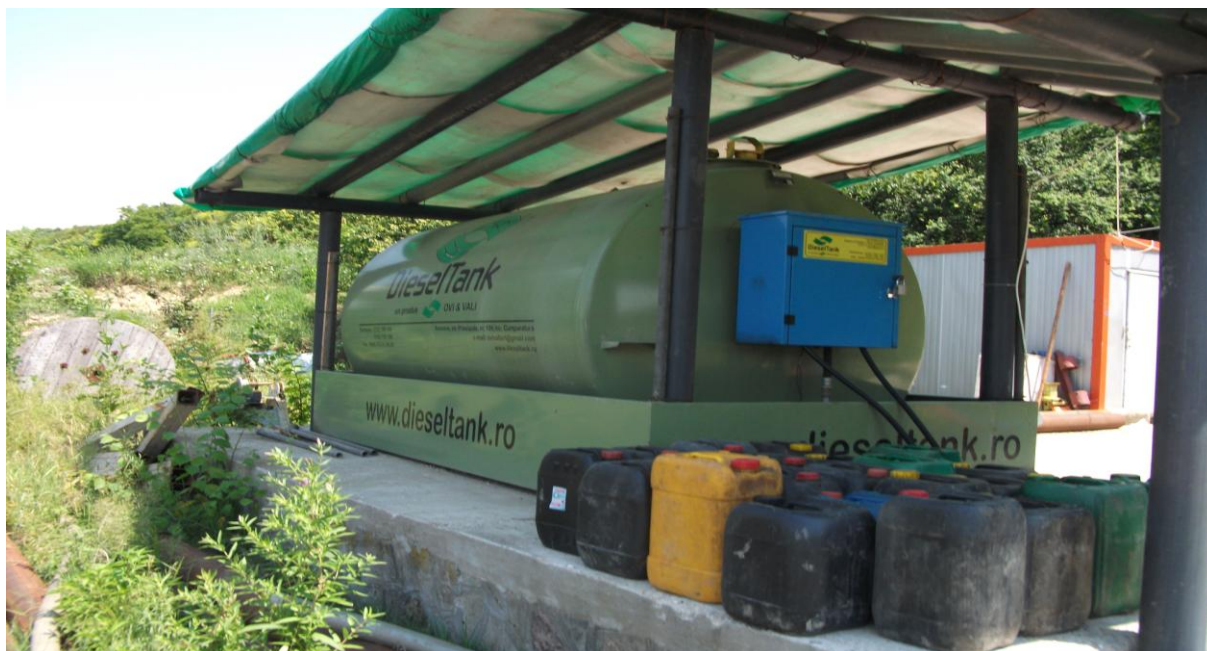
Fig.2.1.1.I.1 - Depozit de carburanți în zona organizării de șantier, PC 01
