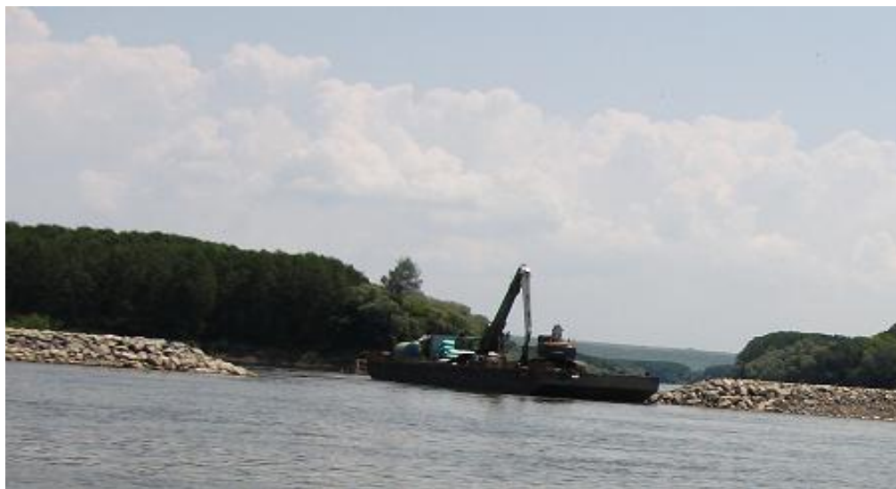
Fig. 2.1.4 - Pregătire pentru pozarea geotextilului în zona digului de dirijare, PC 02
