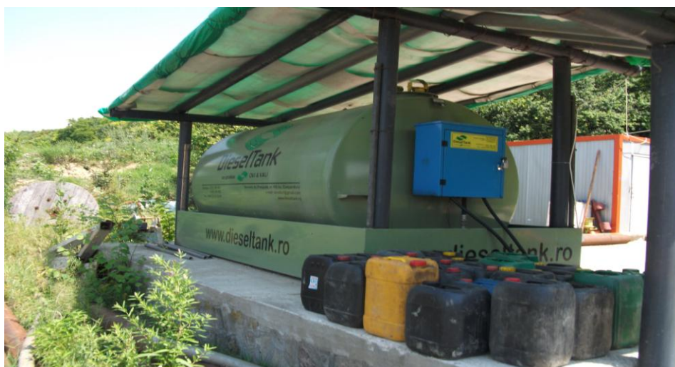
Fig. 2.1.3 - Depozit de carburanți în zona organizării de șantier, PC 01
