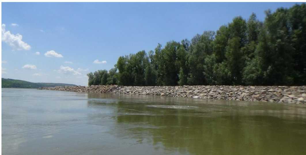
Fig. 2.1.2 - Dig de dirijare construit în zona PC 01- Braț Bala-mal stâng
