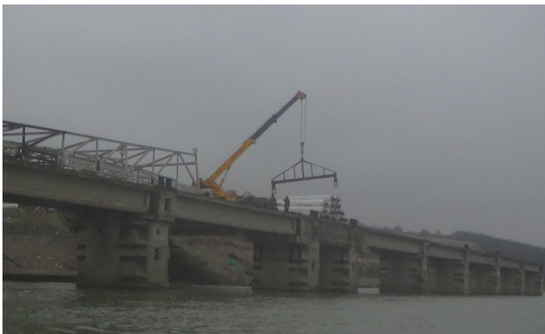
Figura 2.1.1 - Depozitarea materialului geotextil pe estacadă, zona PC 01
