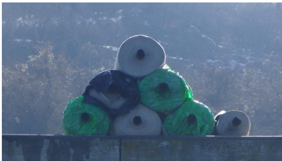
Fig. 1 - Depozitarea materialului geotextil pe estacadă, zona PC 01
