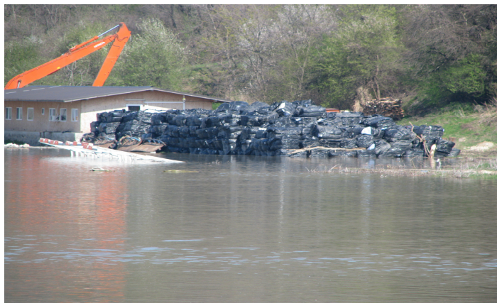
Foto 1 - Depozit saltele geotextil în incinta organizării de șantier
