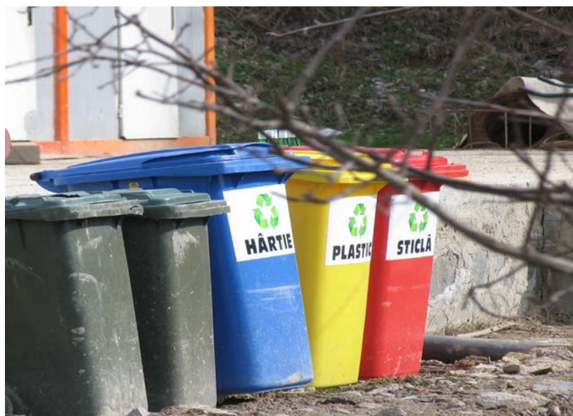
Foto 3 – Depozit deșeuri menajere în incinta organizării de șantier
