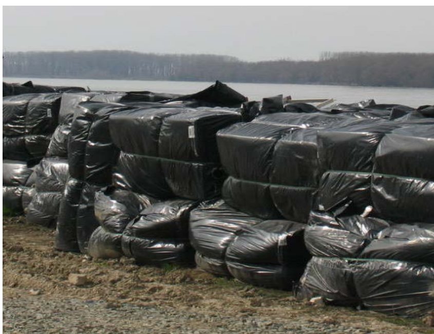
Foto nr. 2 - Depozit saltele geotextil în incinta organizării de șantier
