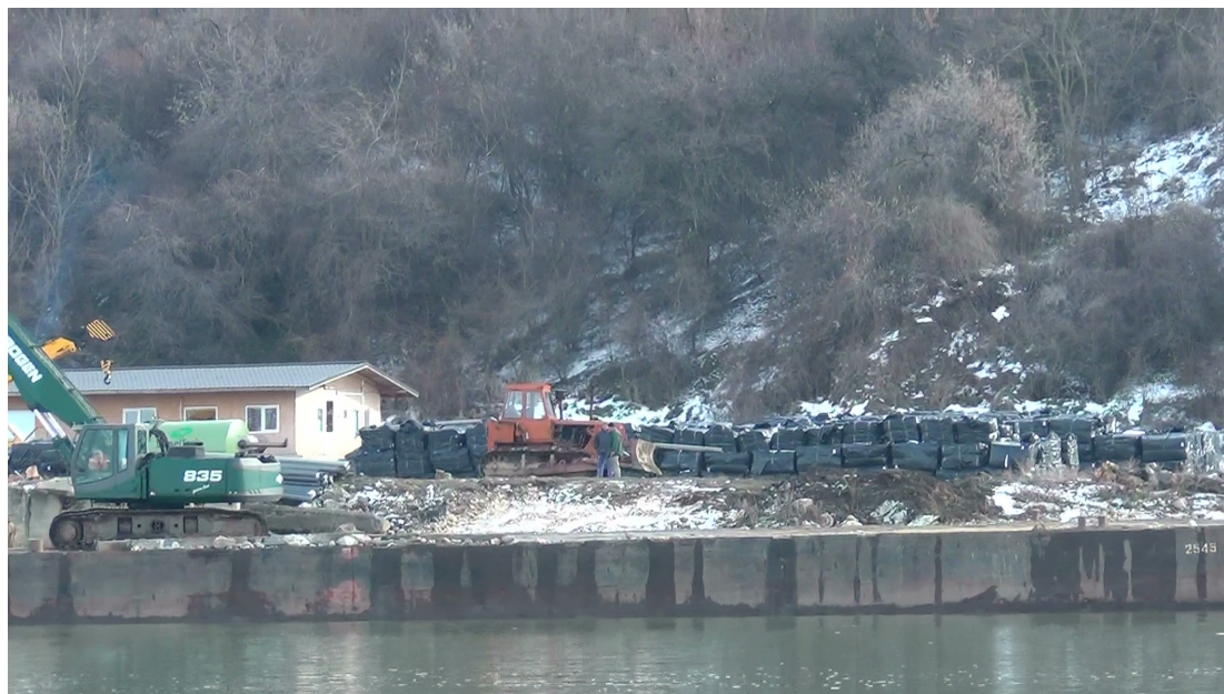
Foto 2 - Depozit saltele geotextil în incinta organizării de șantier
