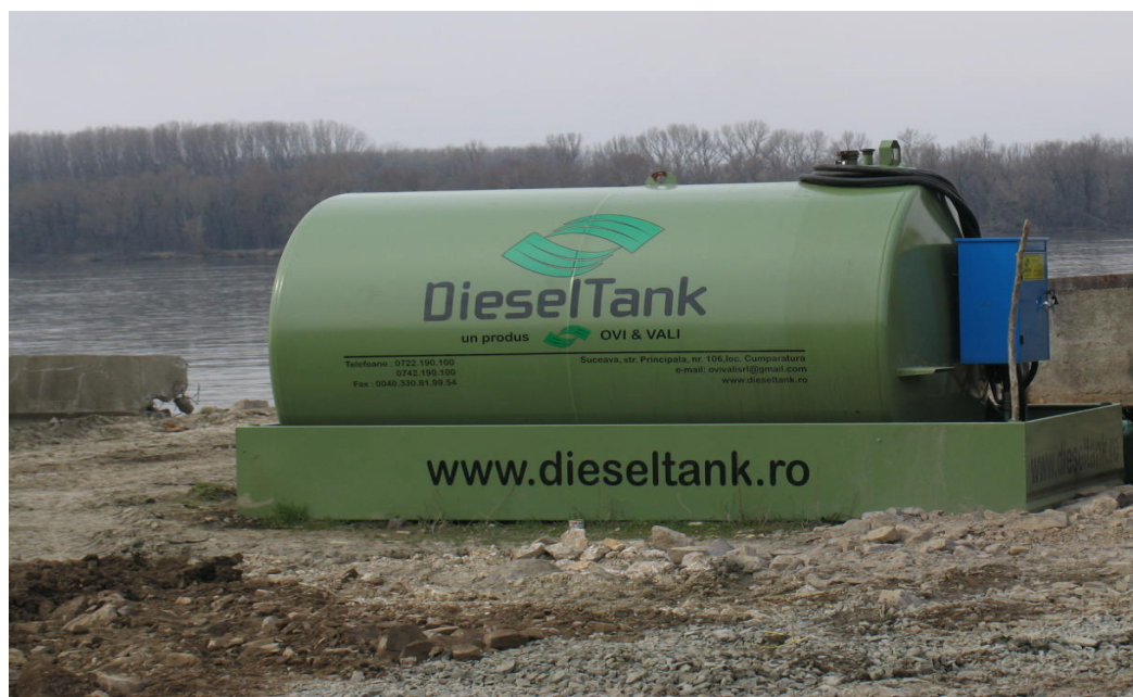
Foto nr.1 - Rezervor metalic stocare carburanți amplasat în cuvă metalică
