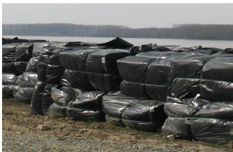
Fig. 2.2 - Depozit saltele geotextil în incinta organizării de șantier
