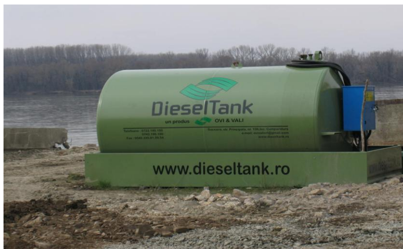
Fig. 2.1 - Rezervor metallic stocare carburanți amplasat în cuvă metalică
