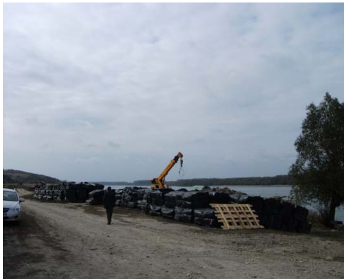
Foto 1 - Depozit saltele geotextil în incinta organizării de șantier PC01
