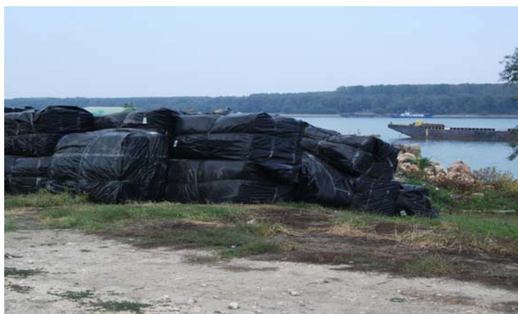
Fig. 2.1.1.I. 3 - Depozit saltele geotextil în incinta organizării de șantier
