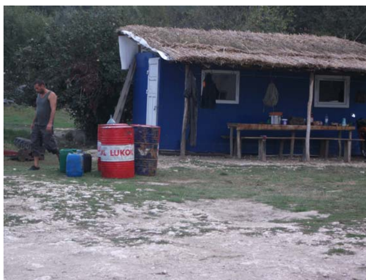
Fig. 2.1.1.1.2 - Zonă de depozitare temporară a uleiurilor minerale existente în organizarea de șantier
