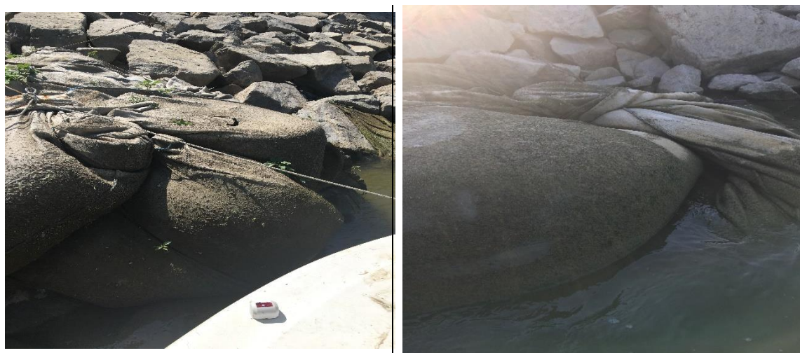
Fig. 2.3.14 - Imagini ce prezintă sacii utilizați la realizarea pragului de fund poziționați la suprafața apei în zona PC01
